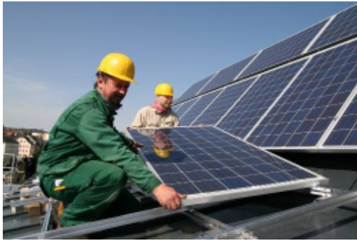
Eine örtliche Firma bei der Installation der Solarmodule; Foto: N. Fugmann
